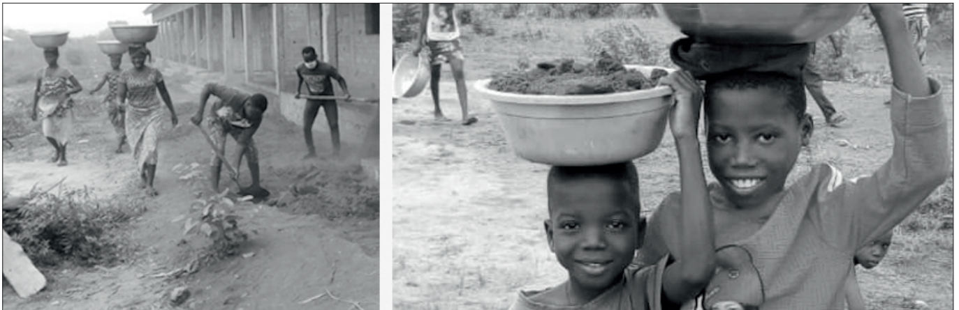
Bei allen Bauprojekten sind die Dorfgemeinschaften von Jung bis Alt beteiligt und helfen mit viel Vorfreude auf die neuen Gebäude mit. Der Bau der Schulen wird für alle Beteiligten in Benin und in Deutschland immer wieder zu einem gemeinsamen, denkwürdigen Ereignis (Aheme, 2020).
